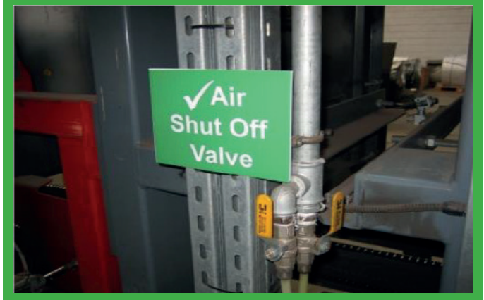
Egyértelműen azonosított pneumatikus leválasztási pont.
