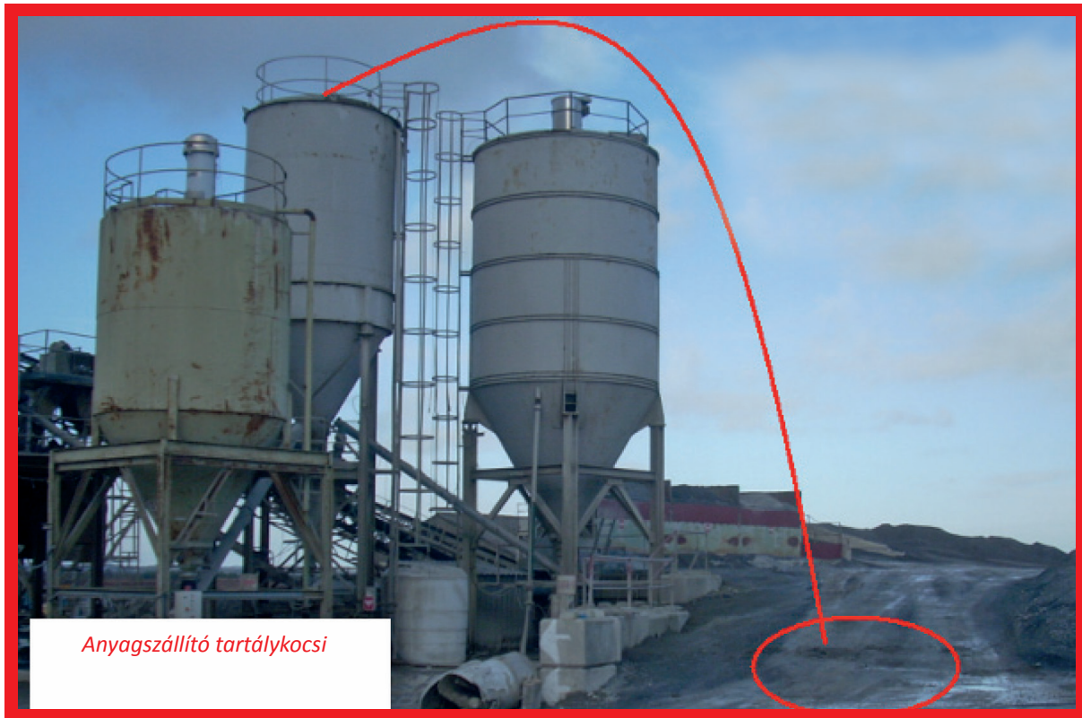
Incidens - Veszélyes helyzet, 2019: Egy szűrő lerepült a silóról
