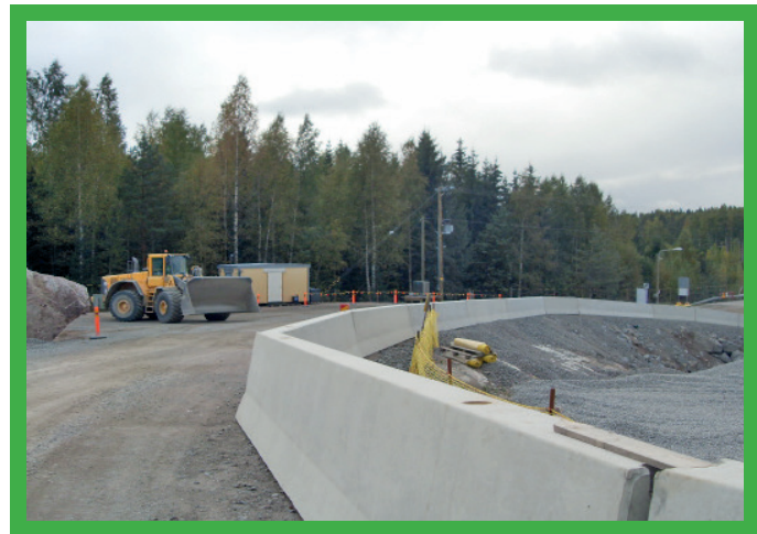
Út szélének védelme előregyártott betonelemekkel
