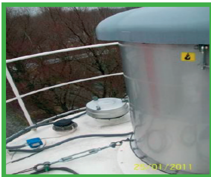
Utolsó védelmi vonal: Szűrő hozzáláncolása a siló szerkezetéhez.
