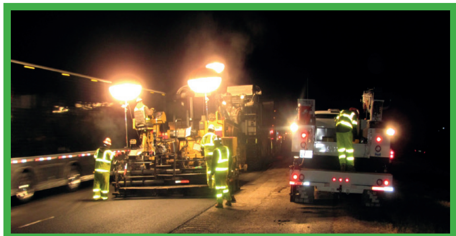
Élő forgalom közelében végzett éjszakai útburkolás.
