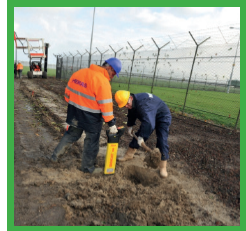
A kerítés felállítása előtt ellenőrizni kell, hogy vannak-e föld alatti kábelek.
