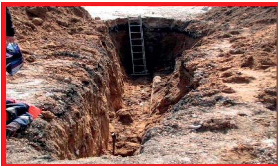
Halálos baleset, 2009: Beomló árok (2,1 m), falképzés/támasztás nélkül.
