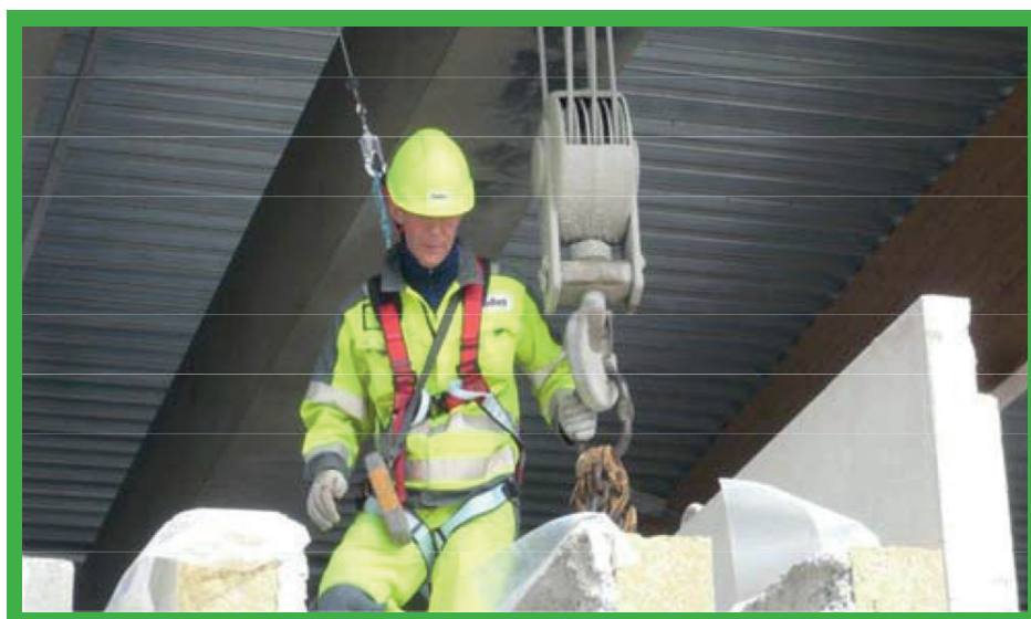
Bezpečný systém prístupu pre pripojenie a odpojenie zdvíhacích popruhov
