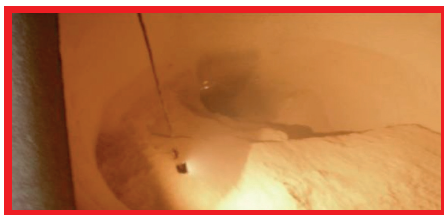
Smrteľná nehoda v roku 2007: Zosnulý sa snažil uvoľniť zablokovanie surovínového sila pomocou provízorého „mosta“ na vstup do sila. Počas práce z tohto mosta sa materiál zhora uvoľnil, narazil do mosta a spôsobil pád obeť. V materiáli sa udusil.
