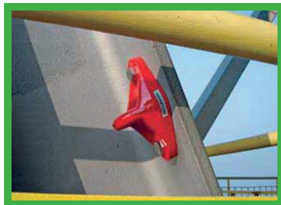
Kotviace body – inštalované v prípade potreby.
