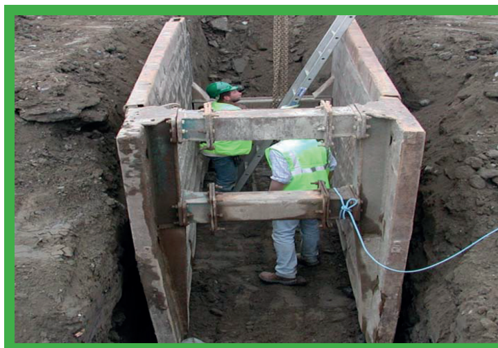
Paženie výkopu v praxi
