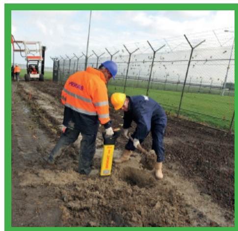
Kontrola prítomnosti podzemných inžinierskych sietí pred výstavbou oplatenia.
