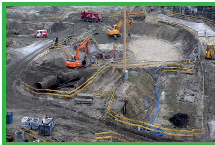
Riadenie dopravy na stavenisku.
