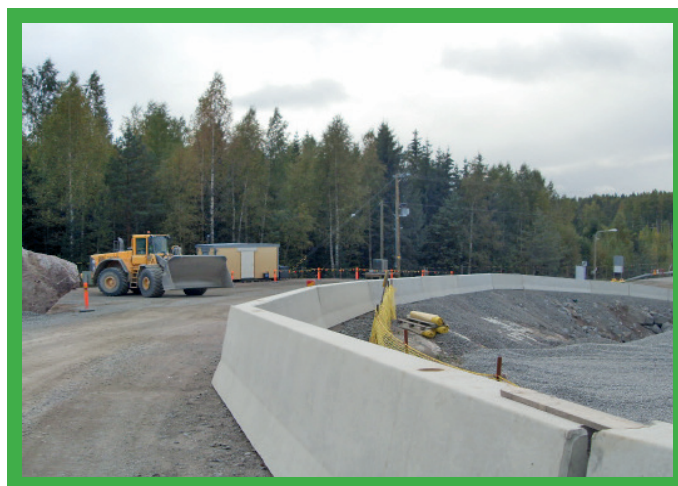
Ochranné bariéry z prefabrikovaných konštrukcií.
