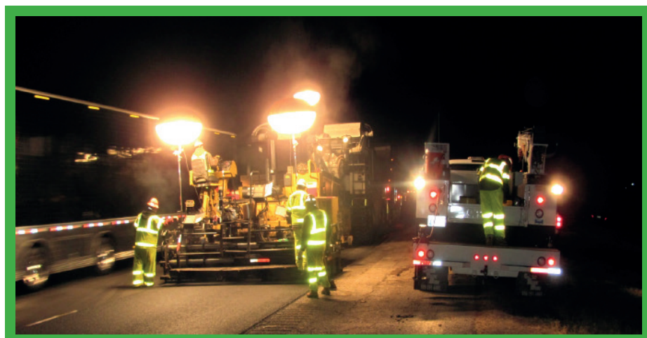
Úprava povrchu vozovky v noci blízko živej dopravy.
